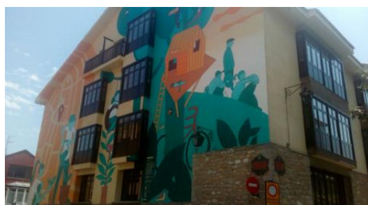
Una vez retirado el andamio, el mural quedó al descubierto, luciendo maravillosamente
